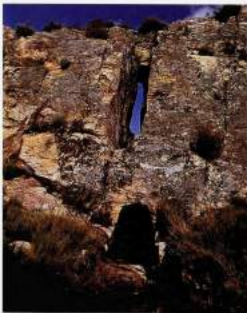
Corta da Ribeirão, Três Minas. Trecho de antiga galeria de arcos com escoamento no telado subterrâneo da corte. Em baixo, a galeria tem altura de seu banco e perfil normalizado de seção trapezoidal.
