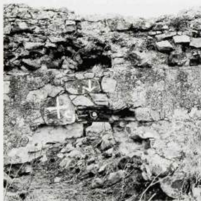
Barragem do Muro dos Muros (Sérgio). Túnel romano de tomada de água.
