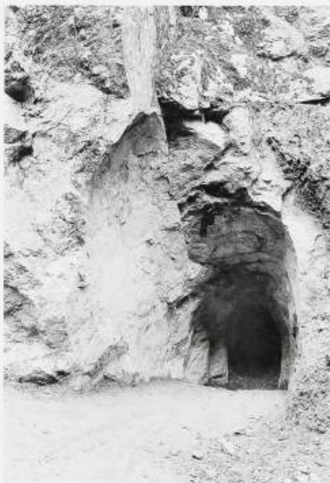
Corta de Cruzes, Três Minas. Frente de desmonte, por aquecimento e resfriamento, no sector principal da corta.
