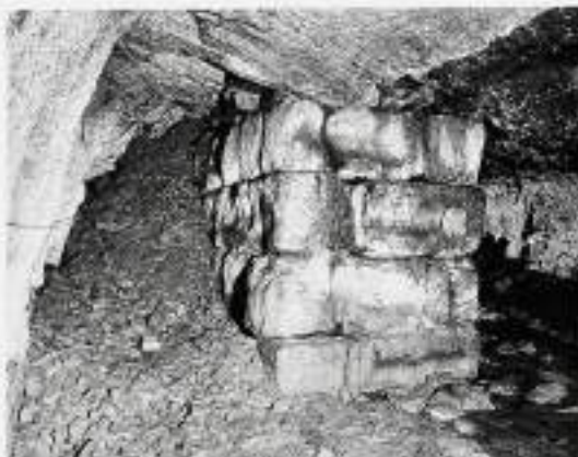
Corta de Corno, Três Minas. Galeria principal de transporte e escoamento. Pilas de proteção construído com blocos de basalto desgastados.
