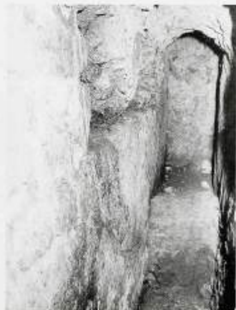
Azenha de Conimbriga. Traço inciso aberto pela roda na concreção calcária do muro adjacente. À direita, espena de posicionamento.
