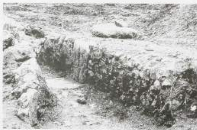
Barragem de Vale Tesnado (Loulé). Tancado de água para a regadião.
