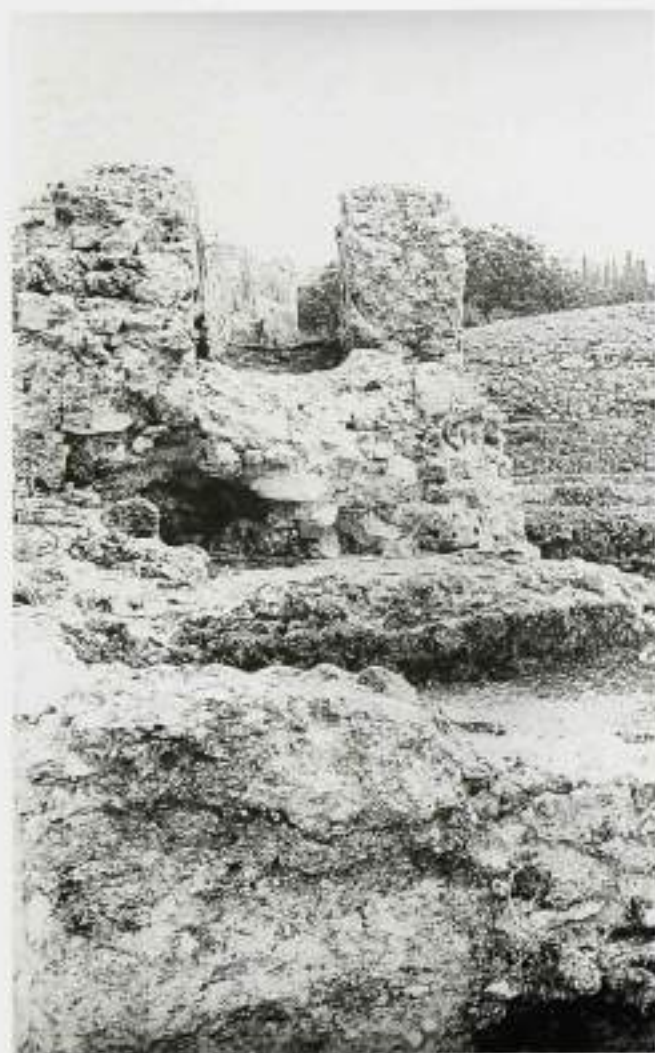
Aqueduto de Casimbreiro. Torre de distribuição
