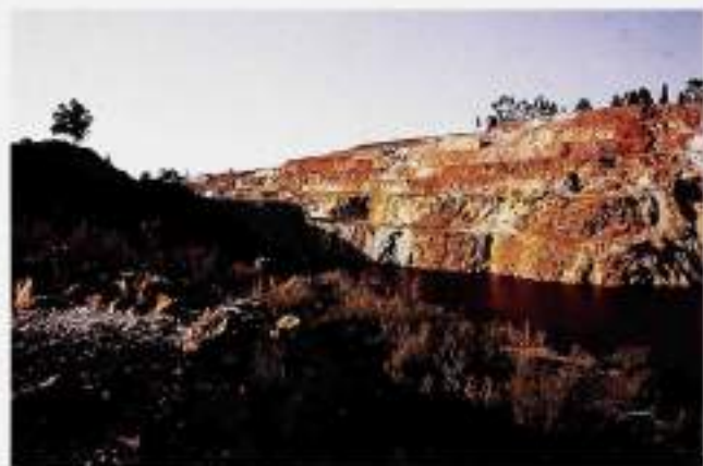
Mina de São Domingos, Alentejo. Vista do talude setentrional da exploração moderna em bancas, abandonada em 1965. Existem galerias e poços da exploração romana cercados até ao nível actual da água, mas não são visíveis na fotografia.
