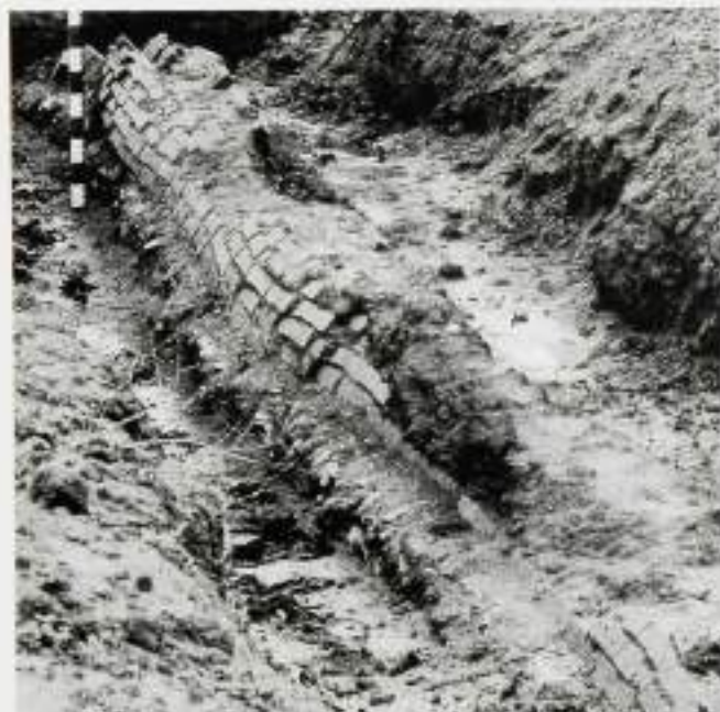
Aqueduto da barragem do Vale de Tevedo (Lusit.) para Cereia da Vêa.
