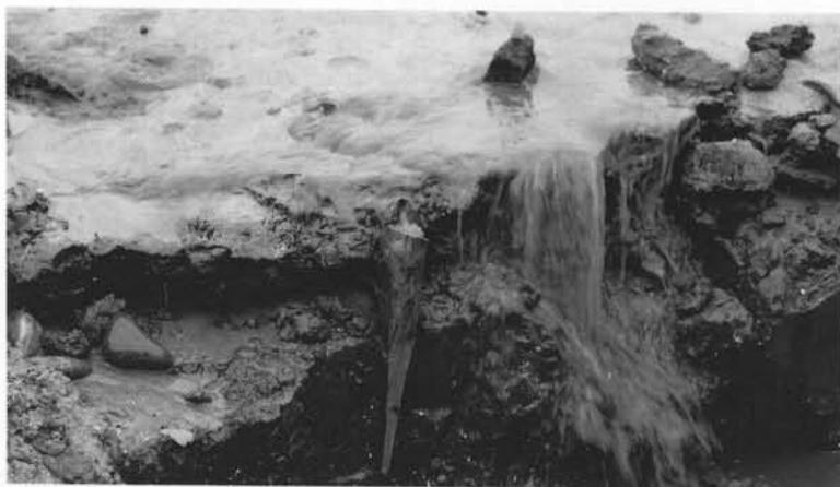
Fig. 29 — Ponta da estaca W3 no perfil da vala aberta.
