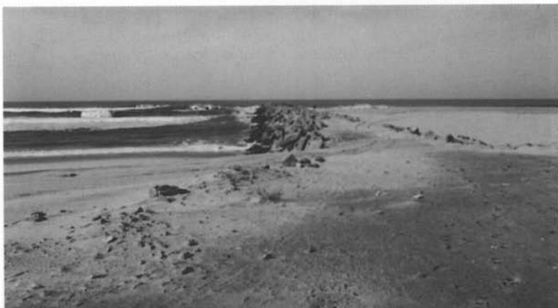
Fig. 7 — Vista do esporão a norte do sítio. Repare-se na acumulação das areias a montante e o fenómeno inverso a jusante, em resultado da orientação da corrente marítima (de norte para sul).
