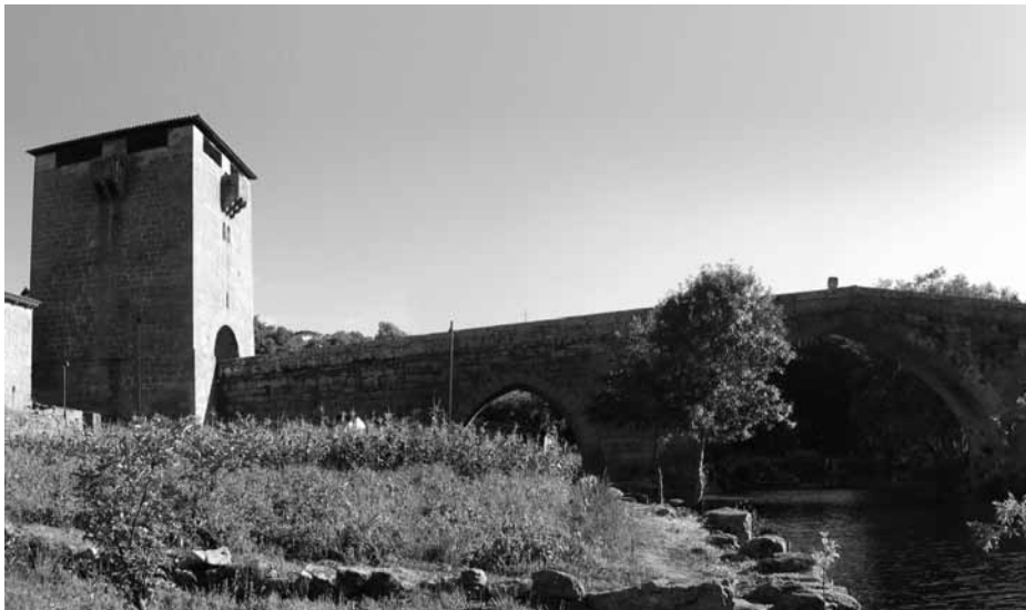
Fig. 1 – A ponte de Ucanha vista de montante para jusante. A torre fica na margem direita do rio Varosa.
