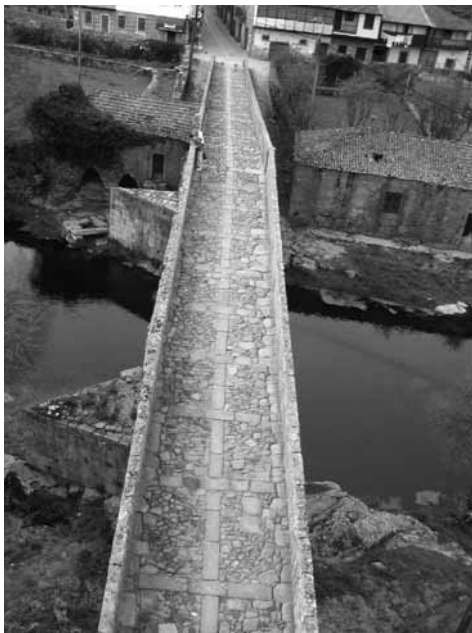
Fig. 6 – Tabuleiro, talhamares e moinhos vistos da torre.
