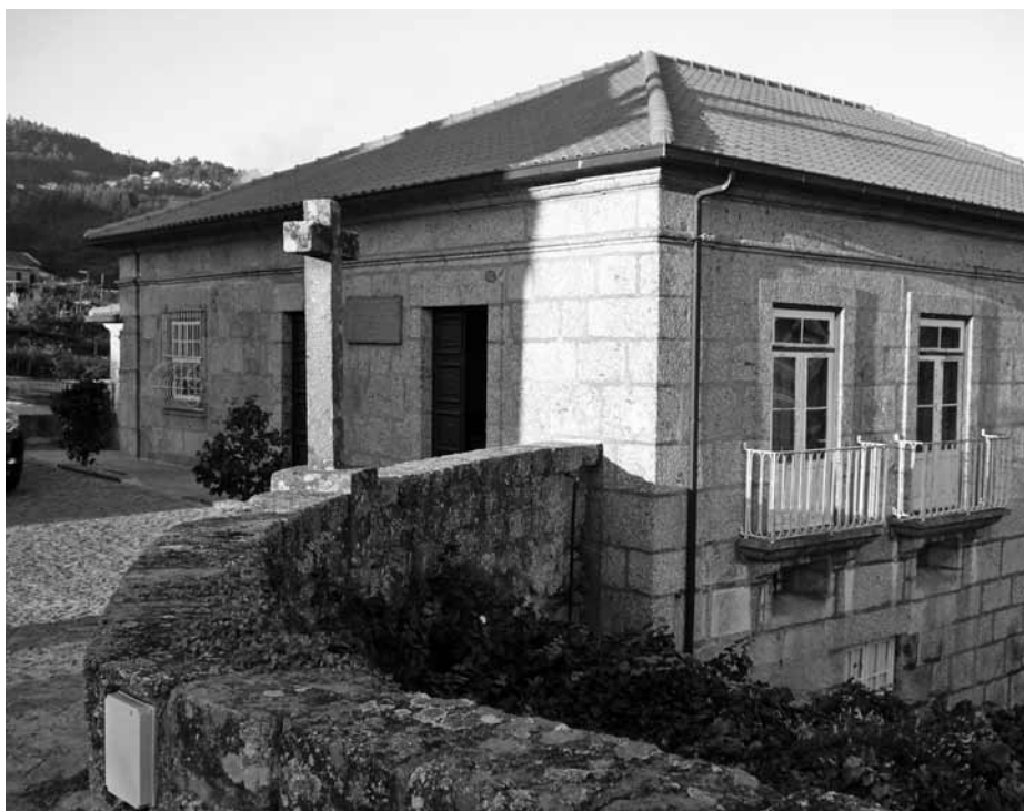
Fig. 2 – Residência paroquial do Abade de Tagilde.
