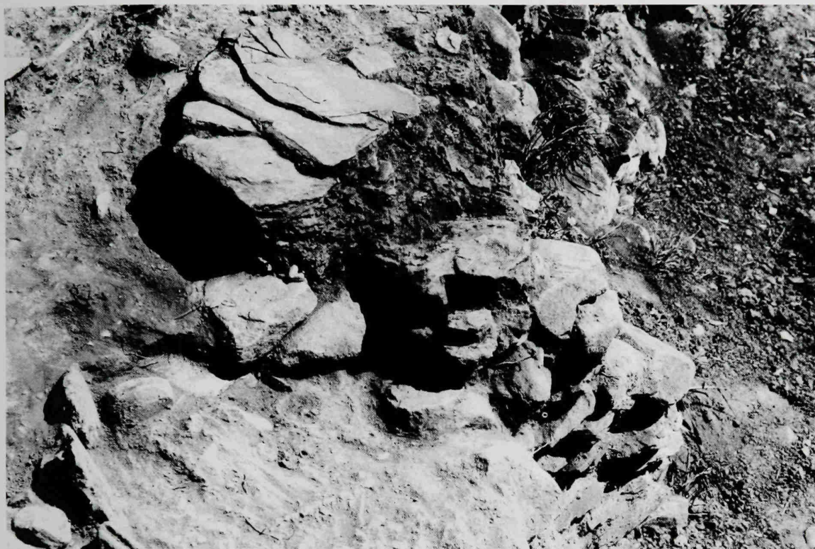
Fig. 10 – Monte Novo dos Albardeiros: interface arqueológica entre o topo da grande torre desactivada e a base da Estrutura tipo tholos , sendo visíveis lajes de xisto em escama de peixe, dispersas no solo primitivo do monumento.
