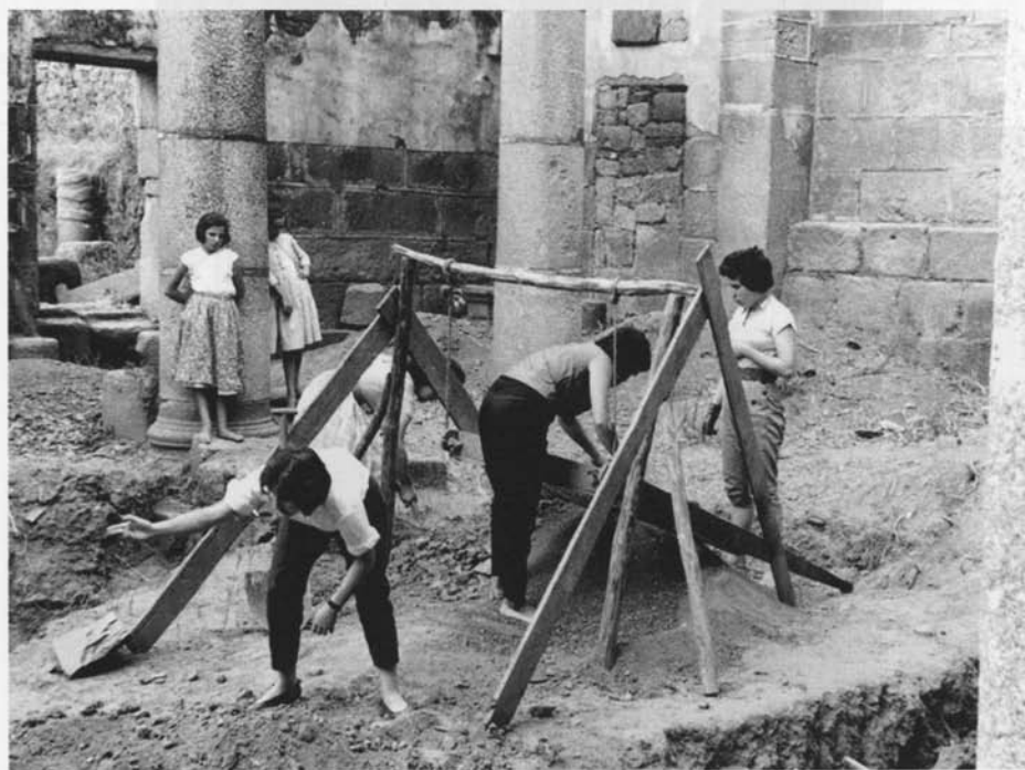
Fig. 12 e 13 – Dois aspectos das escavações dirigidas por D. Fernando de Almeida na Sé de Idanha-a-Velha, em 1959.
