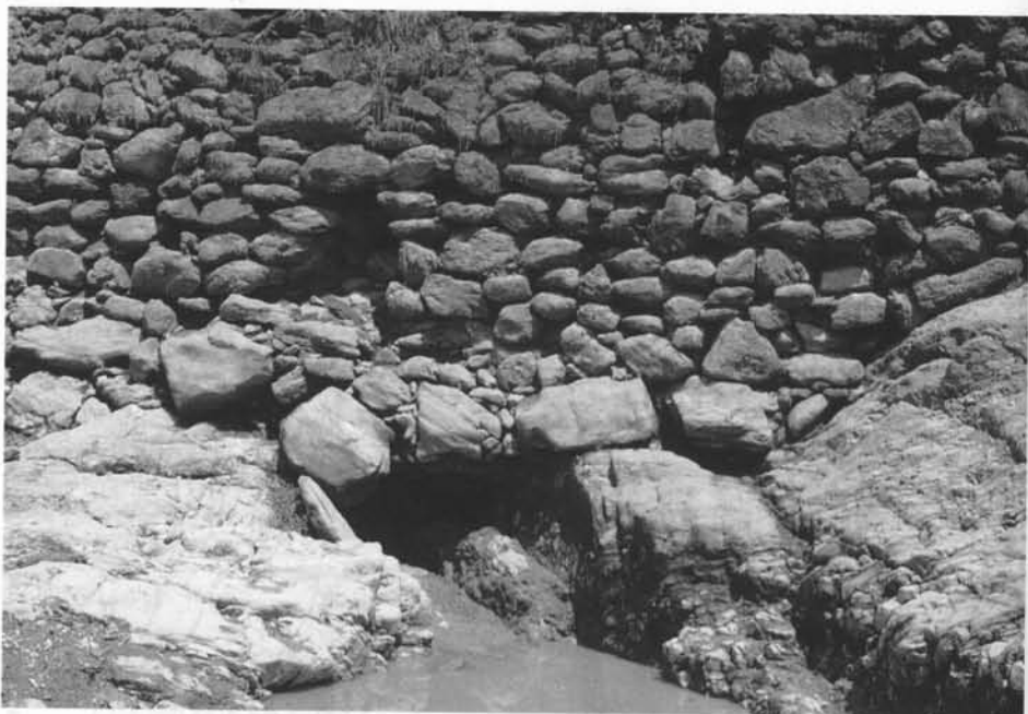
Fig. 5 – Pormenor do paramento da barragem e eventual descarga de fundo.
