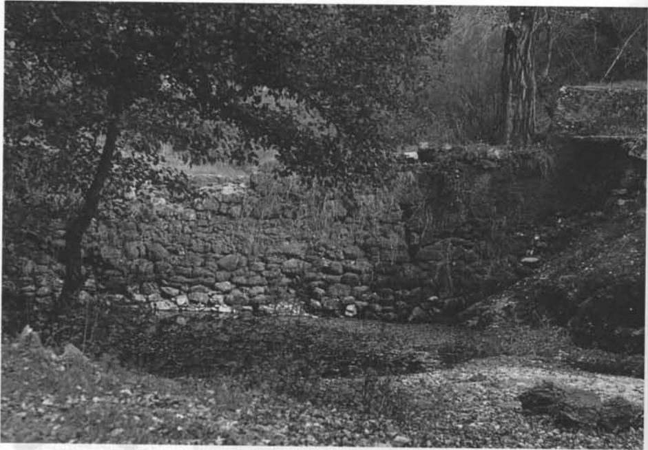
Fig. 11 – Pormenor do paramento juzante da barragem.
