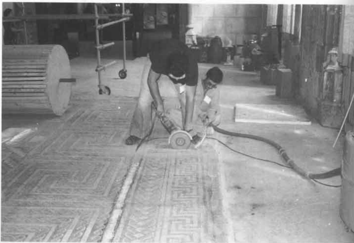
Fig. 5 – Corte em placas do mosaico das musas para facilitar o seu levantamento. 1982. (Arquivo Fotográfico do MNA).
