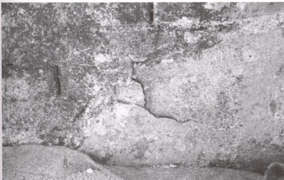
Fig. 4 – Degradação física de um *opus signinum* provocado pela elevada resistência mecânica das argamassas de cimento Portland aplicadas na zona.
