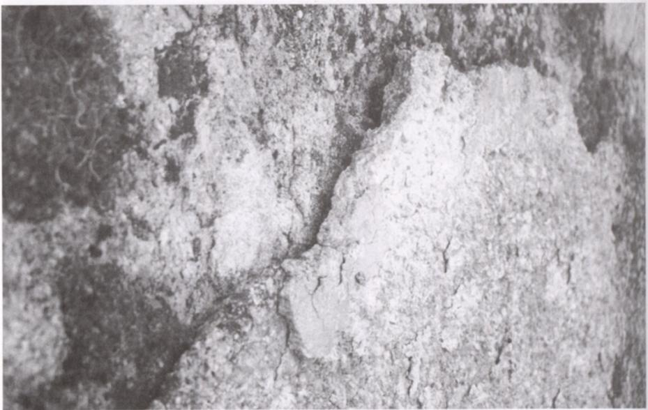
Fig. 5 – Degradação química de um *opus signinum* provocada pelo ataque do meio e de microorganismos a que ficou exposto após a escavação.
