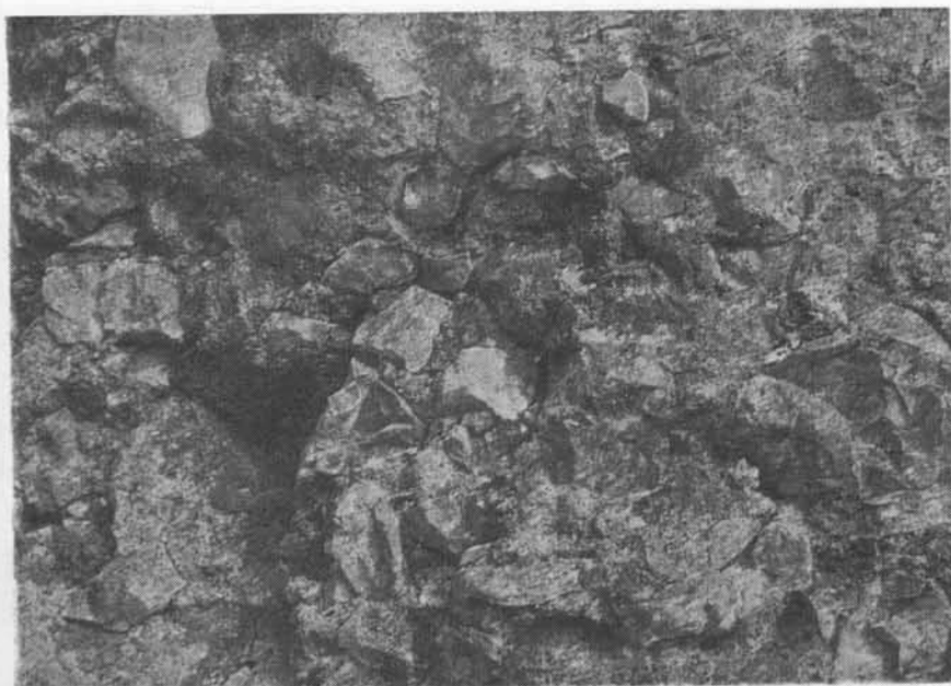
Fig. 6 Enchimento entre os paramentos
